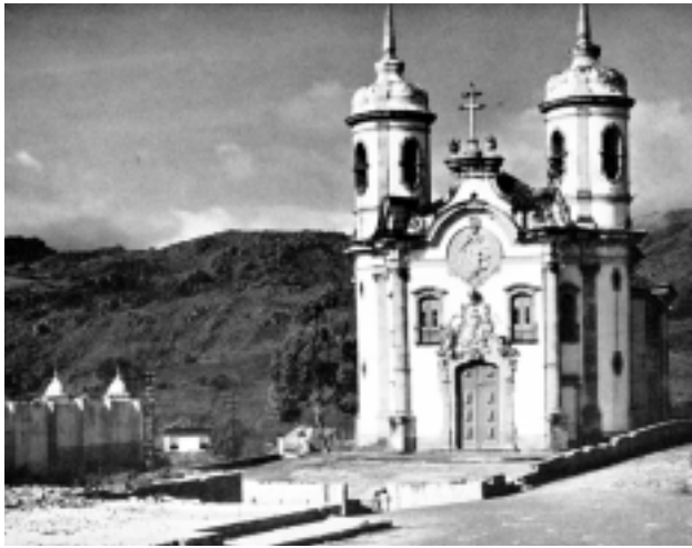
FIGURE 10. Largo do Coimbra after the demolition of the market. (Photo courtesy of Laboratório de Fotodocumentação, Escola de Arquitetura, UFMG.)
